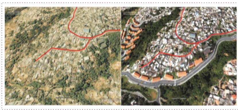
Figura 14: Eixos estruturantes na favela da Serra antes e depois, com Avenida do Cardoso. Fonte: Adaptado de BRAGANÇA (2020).
