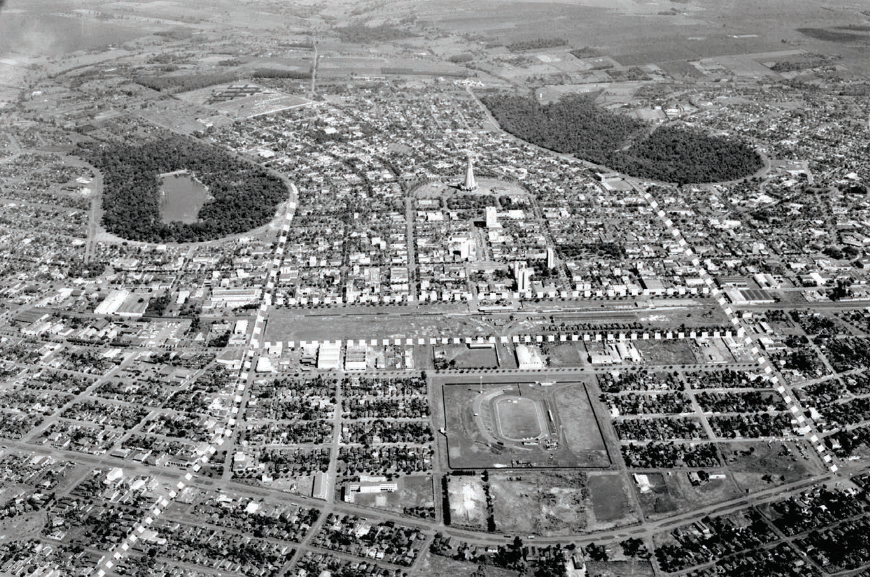
FIGURA 23 Pátio de manobras e estação ferroviária na década de 1970 e duas vias de passagens no centro destacados em linha tracejada branca.
