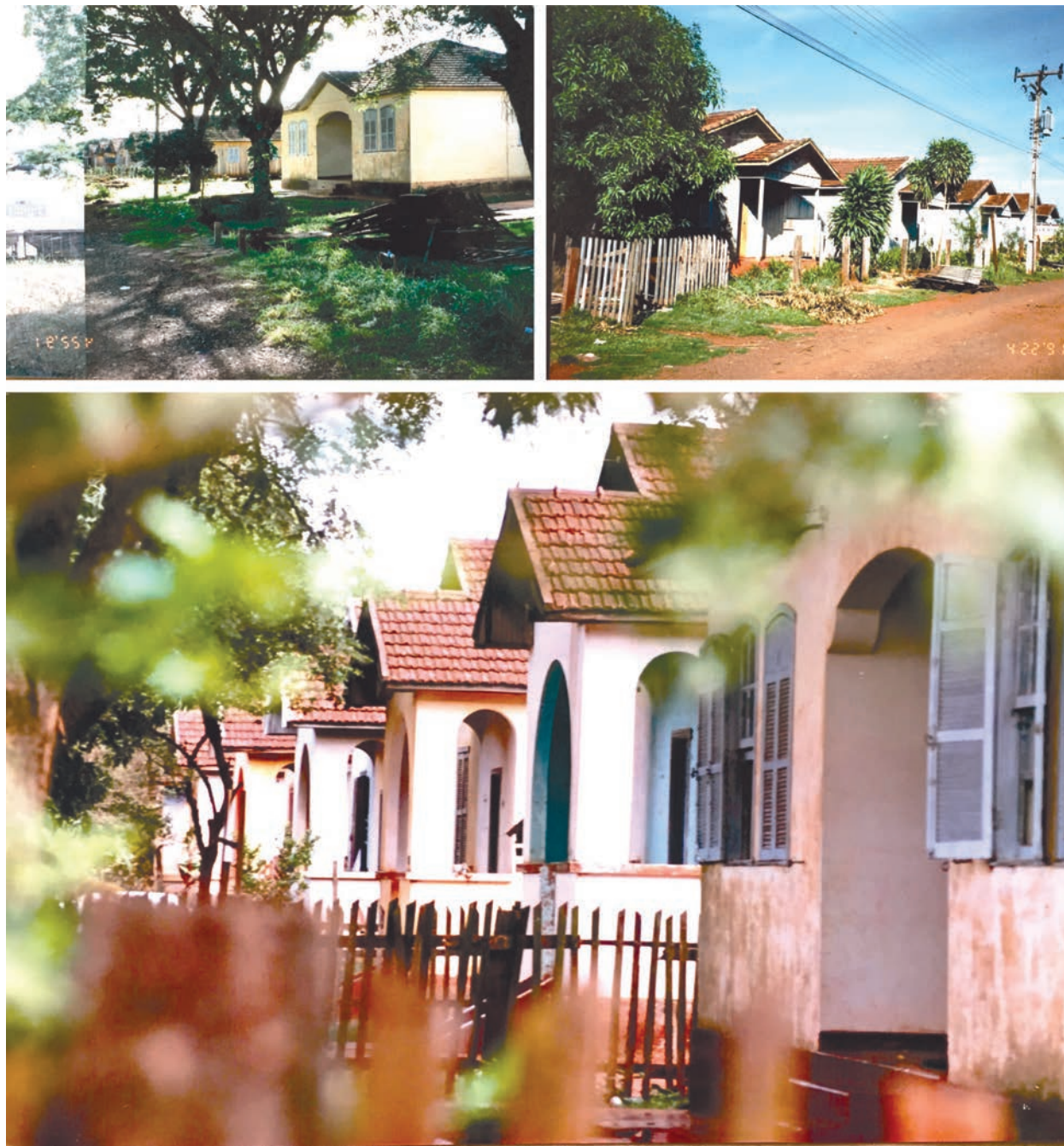
FIGURA 7 Imagens das residências dos operários e diretores ferroviários no ano de 1991, antes da demolição.
