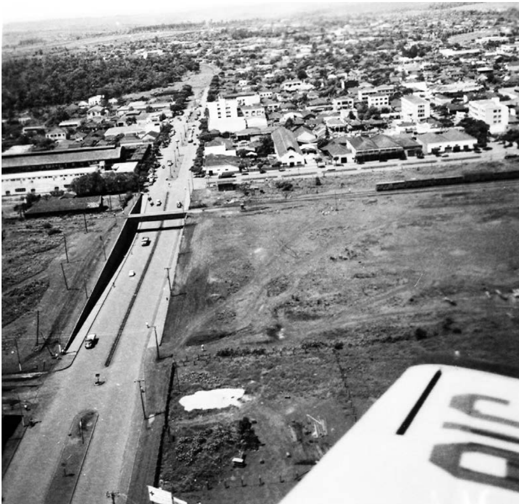
FIGURA 19 Foto mostrando o Viaduto do Café concluído.
