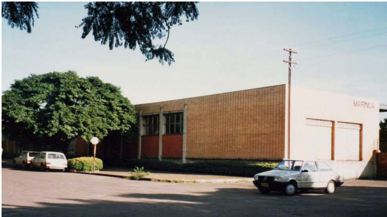
FIGURA 1 Estação Ferroviária em abril de 1991. A edificação seria demolida na sequência, após a erradicação da Vila dos Ferroviários.
