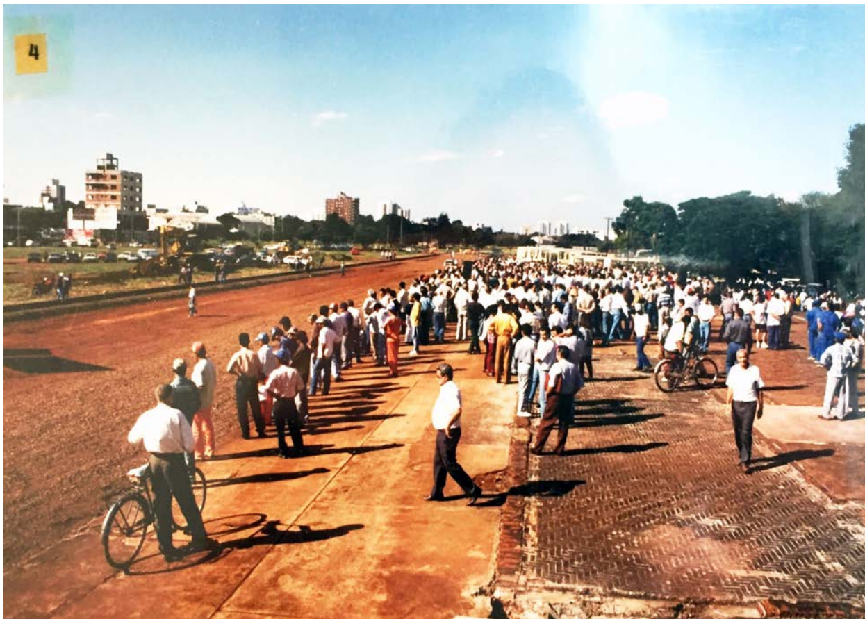
FIGURA 4 Início das obras de rebaixamento da linha férrea em 23 de junho de 1995.
