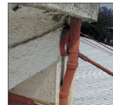
FOTO 01 - IMG_0530 Vista externa do tubo
