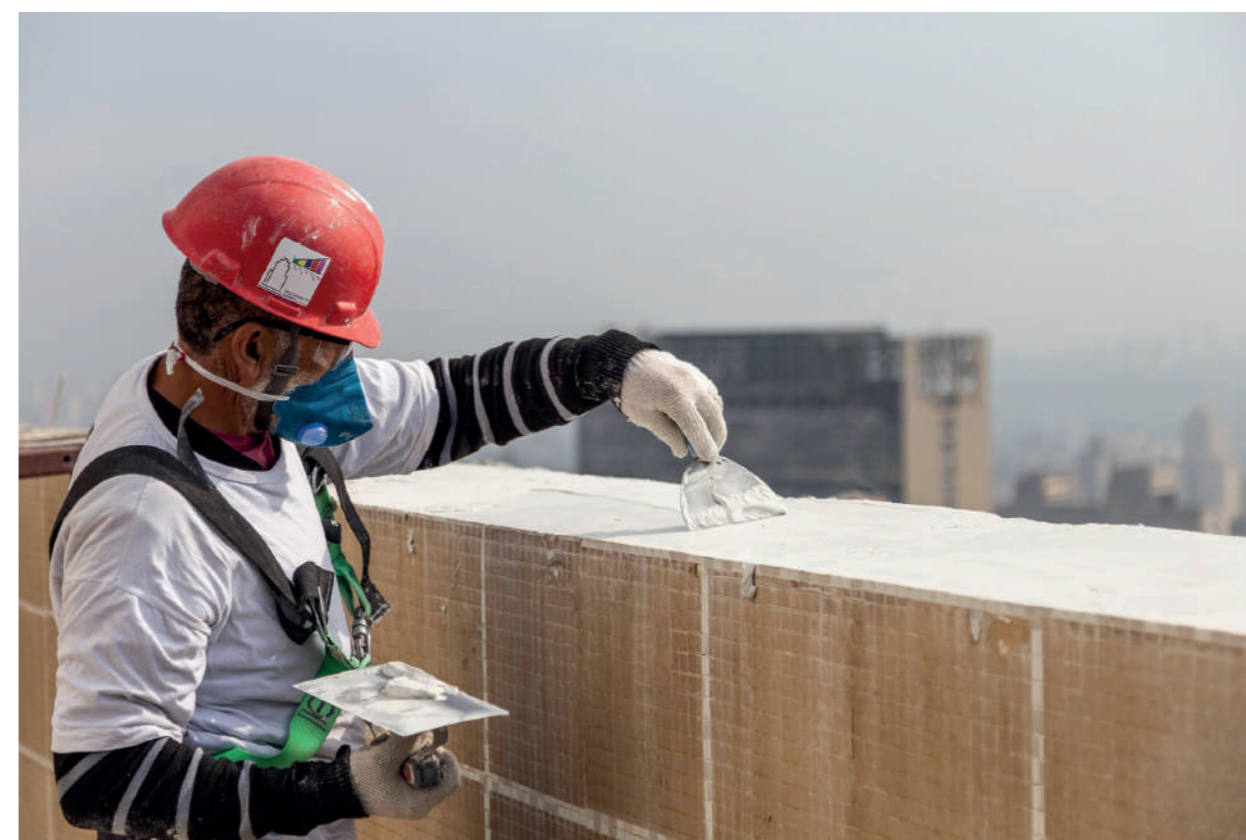
Restauração da fachada do Farol Santander - Edifício Altino Arantes em São Paulo, SP. Crédito da foto: Léo Giantomasi (fotógrafo de arquitetura)/ Acervo do autor.
